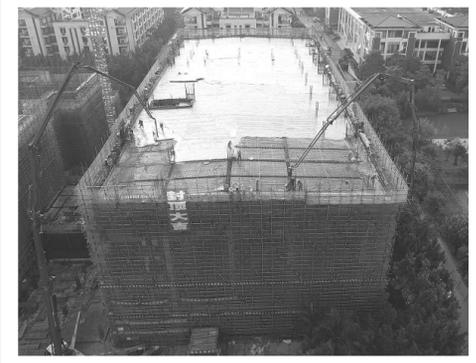
日前,由广西建工第一建筑工程集团有限公司承建的广西民族大学思源湖校区大学生活动中心项目,实现了综合训练馆主体结构顺利封顶,标志着综合训练馆的课题研究工作进入下一阶段。在综合训练馆屋顶混凝土浇筑施工现场,科研团队设立高大支模监控系统,密切监测监控应力变化;当传感器的反馈发现混凝土浇筑产生的力学指标波动进入警戒范围时,监控站立即向作业的现场管理人员发出停缓施工的指令。
