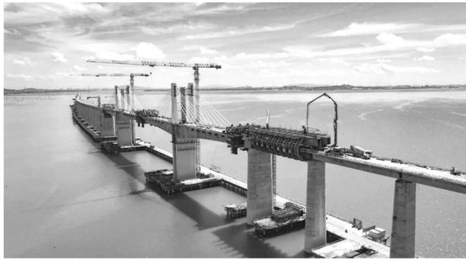
11月13日,新建福州(厦)门铁路湄洲湾跨海大桥成功合龙,标志着新建厦福铁路关键控制性节点顺利打通,为如期建成通车打下坚实基础。据了解,湄洲湾跨海大桥长14.7公里,海域施工长度10.8公里,共有28根斜拉索,施工精度高、技术难度大,是国内首座跨海高铁矮塔斜拉桥。由于湄洲湾海域风大浪急、潮汐明显,水文、地质环境复杂,施工方成立科研攻关小组开展施工技术攻关,推广使用新工法、新工艺,解决施工难题的同时提升施工工效。据中铁十一局厦福4标五区项目部经理许平华介绍,“整个湄洲湾跨海大桥在泉港段,主要的都是重难点工程,一个是40米移动模架,包括斜拉桥主跨,这都是在泉港段,因为它的要求,像40米的移动模架,也是全国首次高铁40米移动模架进行施工,目前已经施工完成,它的精度要求比较高,难度也大一些。”
