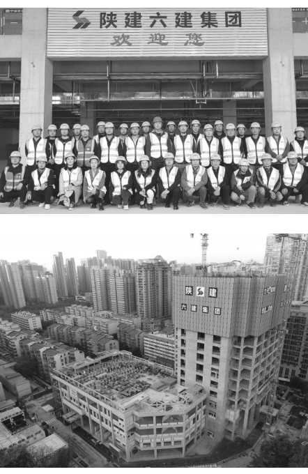
大数据项目总高138.2米,18层以下是混凝土结构,18层—20层是型钢混凝土结构,20层以上是钢结构,钢结构架基本都是在100米以上施工,而且工程幕墙形式多样,集石材、玻璃、铝板、穿孔铝板为一体,幕墙本身与主体结构呈夹空造型,施工工艺要求高。另外项目整体没有标准层,大量的非标高标号混凝土、高支模体系、大跨度预应力梁和大截面柱子等超大构件的联合应用让施工难度再次加大。
