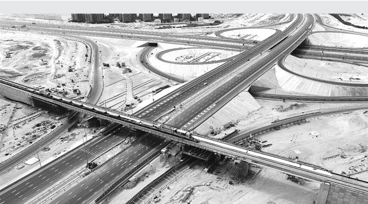
日前,由中国铁建股份有限公司中国土木承建的阿联酋铁路二期项目C标段主线铺轨顺利贯通。此次贯通标段主线全长76公里,是连接阿布扎比、迪拜、沙迦三个酋长国的重要纽带,也是伊提哈德铁路网二期项目中的关键区段。
