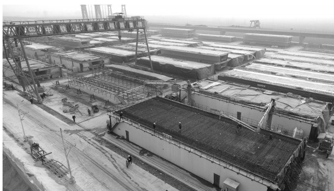
标长清黄河特大桥工程建设,正线长度33公里。
