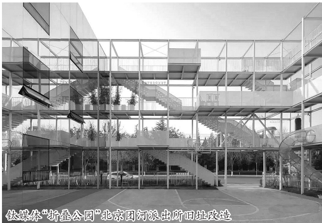
铁媒体“折叠公园”北京团河派出所旧址改造
