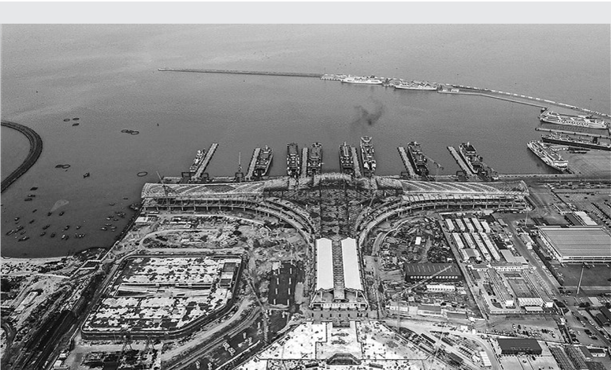
2月7日，海南省海口新海滚菜码头客运综合枢纽站工程和交通枢纽(GTC)工程在紧锣密鼓地进行施工。目前，该项目枢纽站钢屋面网架提升已全部完成，全面进入室内装修和金属屋面铺设阶段。据了解，该项目建成后将大大提高新海港的接待服务水平，增强港口在自由贸易“一线放开、二线管住”背景下的口岸监管能力，同时还对实现港口化进出，促进海口港产城一体化发展、打造国际旅游消费中心具有重要意义。
