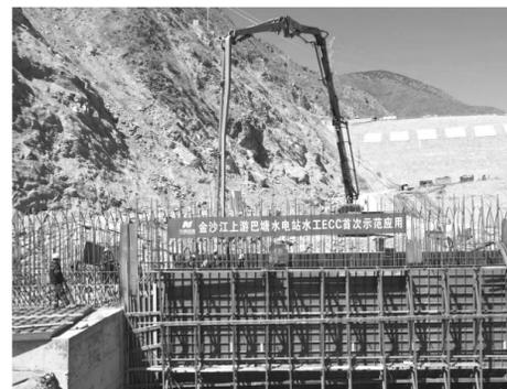
3月7日, 中国安能三局巴塘项目部水工ECC塑性接缝段新廊道首仓浇筑成功完成。这是水工ECC高延性混凝土在水利水电施工中的首次应用。 本次在廊道水平段浇筑的ECC高延性混凝土是以水泥、石英砂等为基体的纤维增强复合材料。与普通混凝土相比, 它具有高强度、高韧性、高抗裂性能和高耐损伤能力。 通讯员 李瑞超 王怀明 摄影报道
