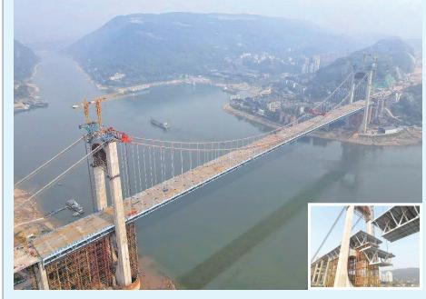
随着最后一块钢桁梁的成 功吊装, 我国国内最大跨度公 轨两用悬索桥——郭家沱长江 大桥3月15日完成合龙。
