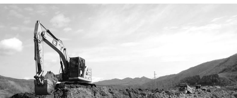
日前,沈佳高速铁路沈白段DK351+785.28-DK353+022.5段路基破土动工。这标志着沈白高铁吉林段TJ-6标路基工程开工建设。
