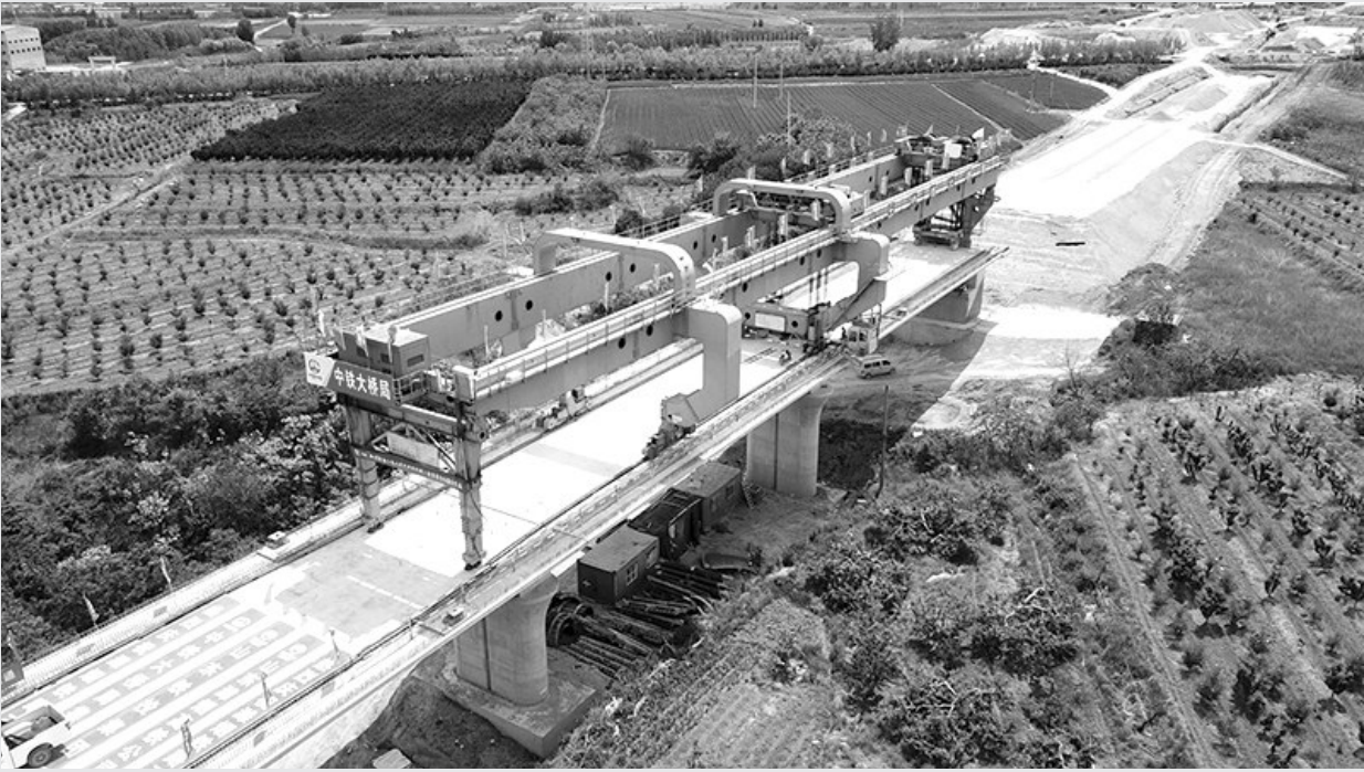
山东省重点基建项目——潍烟高铁施工方在严格防控疫情基础上,积极复工复产。由中铁大桥局承建的潍烟高铁招远段日前实现贯通,为后续铺轨施工奠定了基础。
