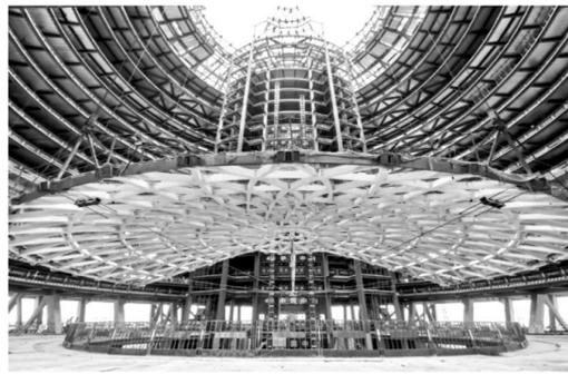
5月13日上午9点,在历经18个小时的间断作业后,一个巨大的蝴蝶状穹顶网壳被缓缓提升到97.4米高空,标志着由中国五冶集团承建的世界最大球形建筑——浙江湖州“太阳酒店·水晶晶广场”项目1号楼顺利完成穹顶提升。
