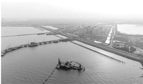
程地铺设首尾两端管线,另一方面积极同政府和相关企业沟通避让事宜,再者就是开展实地考察对管线方案进行缩减优化。最终,历时50天,管线铺设任务顺利完成,并在沿途布设了可视化监控系统,实行全覆盖、无死角式监管,进一步提高了管线的通畅率。在后续绞吸挖泥船首次进港管线路施工后,15公里的陆上纳泥直吹一次成功,顺利打破国内单吹填直排距最长纪录,极大地增强了团队的信心。
