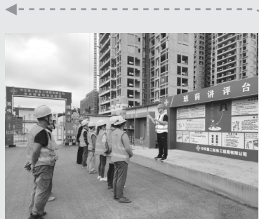
班前5到10分钟,看似短暂,却是施工上岗前的第一道安全关卡。近期,中交二航局贵阳中交·春风景里项目一标段项目部一改以往工地班前会的“老面孔”,规范流程,扎实开展班前喊话,使其成为工地安全管理的“新阵地”。通讯员 方国俊 王俊杰 摄影报道
