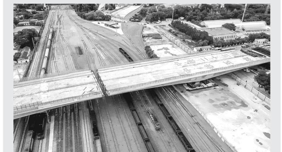
6月22日凌晨2时18分,随着黑龙江省齐齐哈尔民航路跨线桥8号墩梁完成逆时针转体95.61度,与7号墩梁实现了精准对接,创下目前我国严寒地区跨度最大、吨位最重的混凝土连续梁结构桥转体之最。由中铁五院、中铁二十三局集团联合承建的齐齐哈尔民航路跨线桥工程是黑龙江省“百大项目”之一。工程全长2.793公里,桥梁部分长897.3米。
