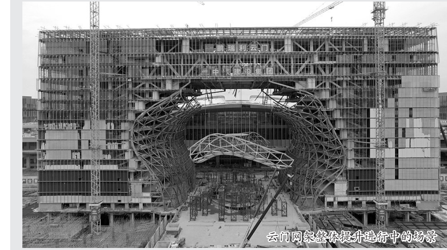
云门网架整体提升进行中的场景
