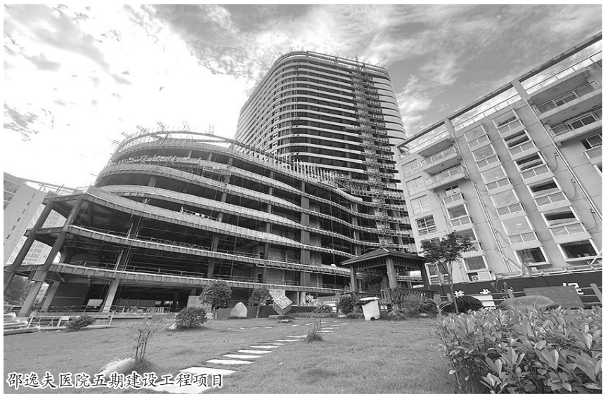
邵逸夫医院五期建设工程项目
