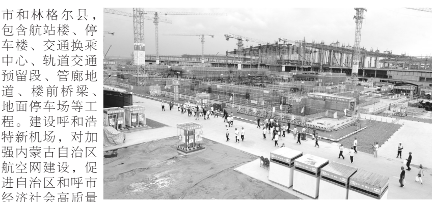
安装、幕墙施工有序穿插施工。停车楼、交通换乘中心已全面进入主体施工阶段, 高架桥正在进行下部结构施工, 管廊地道和轨道交通预留段土方开挖全面展开。
