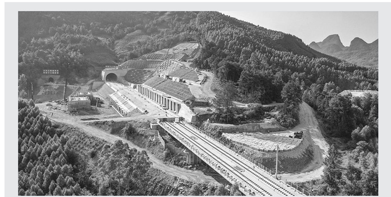
8月4日, 由中铁十二局承建的贵南高铁大方山隧道顺利贯通。大方山隧道位于广西环江毛南族自治县境内, 全长9647米, 所处区域为典型的喀斯特地貌山区, 是贵南高铁广西段溶洞遇见率最高的隧道。贵南高铁是我国“八纵八横”高速铁路主通道内蒙古包头至海南海口通道的重要组成部分, 设计时速350公里。曹伟铭 摄影报道
