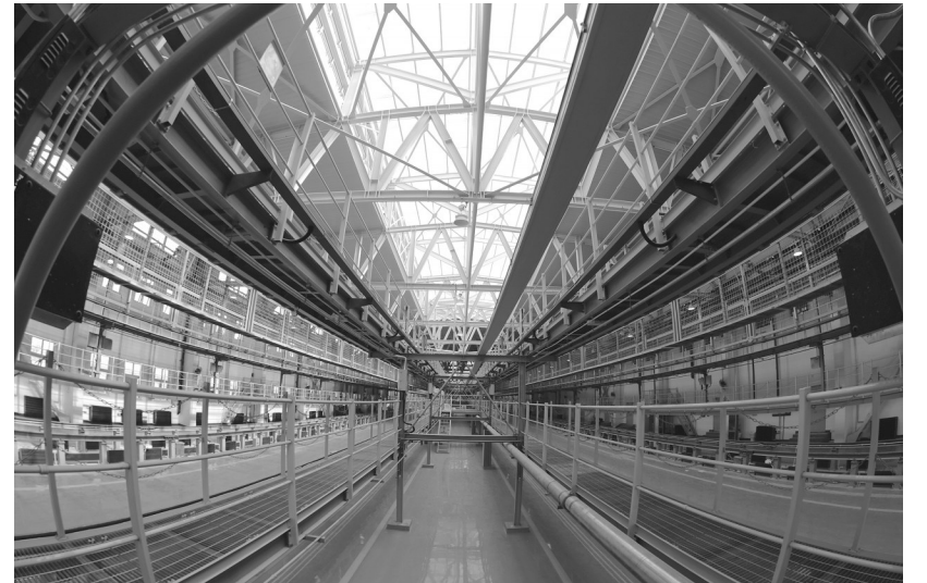
8月4日, 中国铁建电气化局第3分公司京唐城际铁路项目部员工在项目大动车所四线库检查调整接触网线。京唐城际铁路正线全长148.7公里, 设计时速350公里。开工以来, 建设者坚持疫情防控和施工生产两手抓, 确保所有节点工程如期完工。目前正在为全线送电和联调试验做准备。通讯员 郑传海 焦红旗 摄影报道
