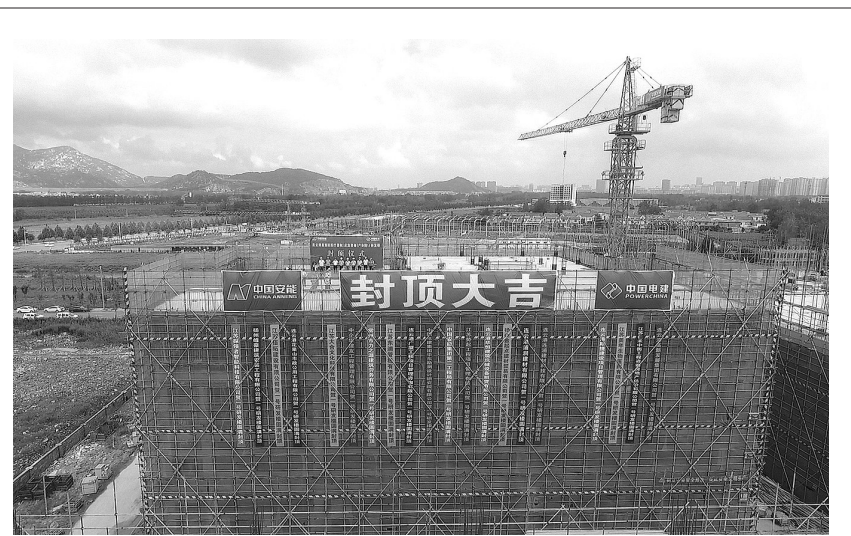
近日, 由中国安能二局常州分公司承建的江苏连云港高新区医疗器械(应急装备)产业园项目1号研发楼封顶。连云港高新区医疗器械(应急装备)产业园位于江苏省连云港市海州经济技术开发区, 项目建筑面积约11.6万平方米, 共建设厂房12栋。其中一期建筑面积约3.5万平方米, 二期建筑面积约8.1万平方米。通讯员 徐迎华 曹灿雨 刘超 摄影报道
