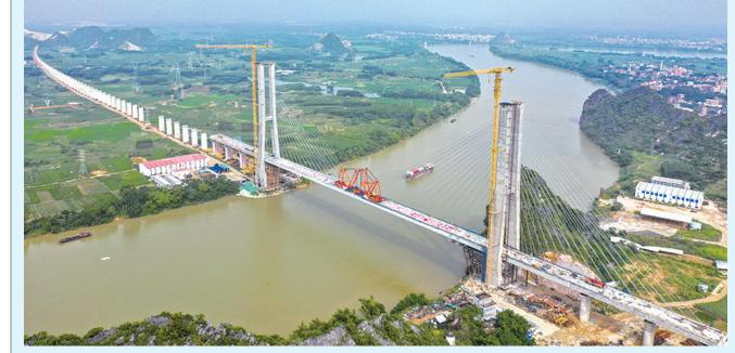
日前,由广西交通投资集团投资 建设,中铁广州工程局承建的世界最 大跨径时速350公里无砟轨道高速铁 路斜拉桥——南玉铁路百合郁江特大 桥顺利合龙, 为全线顺利通车奠定了 坚实基础, 这标志着我国高速铁路大 跨度斜拉桥建设取得新突破。
