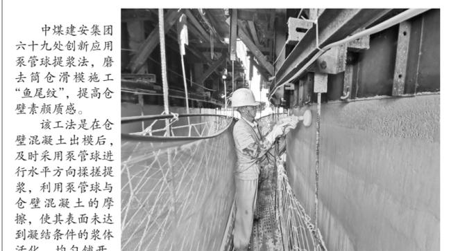
中建建安集团六十九处创新应用泵管球提浆法,磨去筒仓滑模施工“鱼尾纹”,提高仓壁颜值质感。
