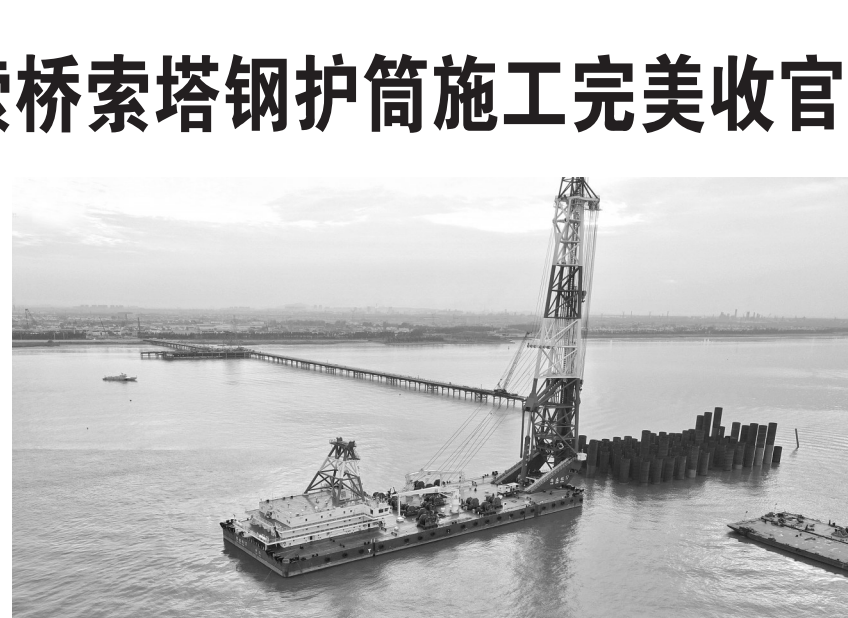
制造、运输、插打作业,为后续桩基施工作业奠定了良好基础。 张靖皋长江大桥连接苏州、泰州和南通三市,跨江段全长7859米,分南航道桥、北航道桥及引桥。其中,南航道桥为主跨2300米的超大跨径悬索桥,是世界最大跨径桥梁,工程将创下6项“世界之最”和6项“世界首创”。大桥共四个主桥墩,其中南航道桥南主塔桥墩是唯一建在长江中的主桥墩,也是全
