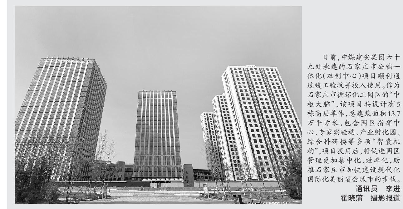
日前,中煤建安集团六十九处承建的石家庄市公辅一体化(双创中心)项目顺利通过竣工验收并投入使用。作为石家庄市循环化工园区的“中樞大脑”,该项目共设计有5栋高层单体,总建筑面积13.7万平方米,包含园区指挥中心、专家实验楼、产业孵化园、综合科研楼等多项“智慧机构”,项目投用后,将促进园区管理更加集中化、效率化,助推石家庄市加快建设现代化国际化美丽省会城市的步伐。 通讯员 李进 霍晓蒲 摄影报道
