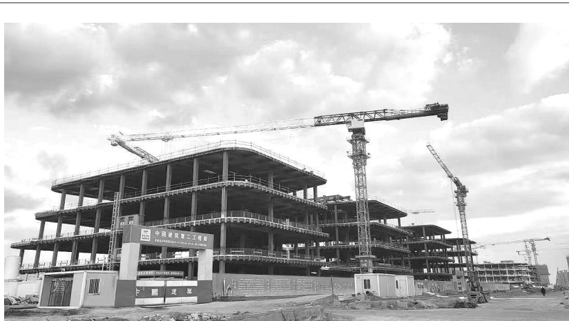
10月27日,中建二局投资建设的上海临港世界顶尖科学家社区项目全面冲出正负零,进入主体结构施工阶段。
