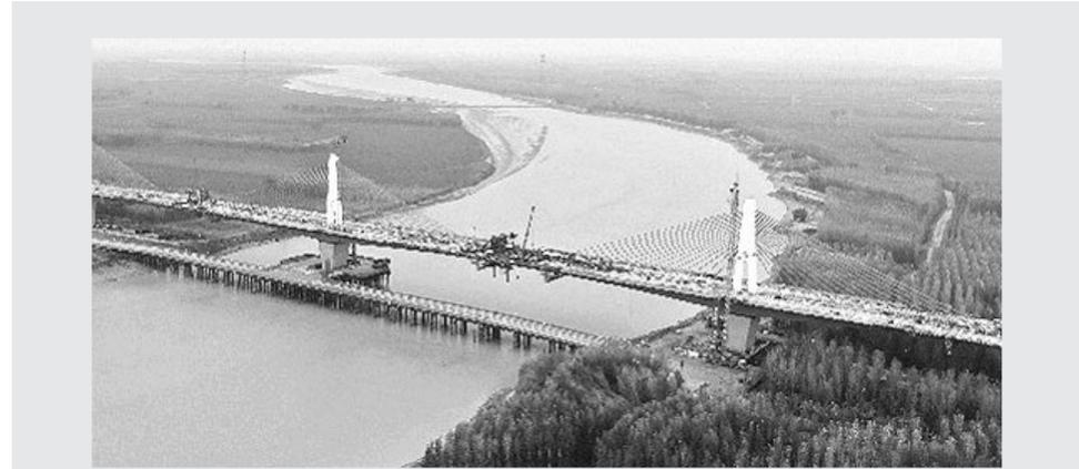
日前,由山东高速集团投资建设的山东济南绕城高速公路二环线西环段项目(以下简称“济南大西环项目”)黄河特大桥顺利实现主桥钢箱梁合龙。
