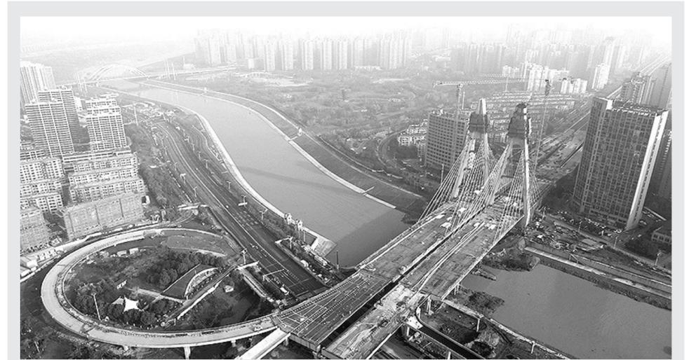
11月24日,由中铁四局承建的引江济淮工程江淮沟通段金寨南路桥主塔封顶。该桥跨越引江济淮工程航道,全长635米,设计为独塔斜拉桥。此次封顶的主塔塔高112米。引江济淮工程沟通长江、淮河两大水系,是我国跨流域、跨省重大战略性水资源配置和综合利用工程。
