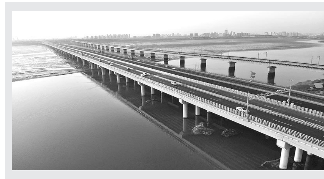
近日, 位于山东省青岛市境内的青兰高速公路改扩建工程女姑口跨海特大桥新建桥体顺利建成通车。该桥是国家高速公路网和青岛市环胶州湾综合交通体系的重要组成部分。大桥全长约3200米, 是青兰高速公路全线最长的单座桥梁和唯一的跨海线路。李紫恒 摄影报道
