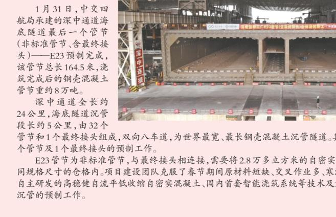
1月31日,中交四航局承建的深中通道海底隧道最后一个管节(非标准管节,含最终接头)——E23预制完成,该管节总长164.5米,浇筑完成后的钢壳混凝土管节重约8万吨。深中通道全长约24公里,海底隧道沉管段长约5公里,由32个管节和1个最终接头组成,双向八车道,为世界最宽、最长钢壳混凝土沉管隧道。其中,中交四航局负责23个管节及1个最终接头的预制工作。E23管节为非标准管节,与最终接头相连接,需要将2.8万多立方米的自密实混凝土浇筑至2159个不同规格尺寸的仓格内。项目建设团队克服了春节期间原材料短缺、交叉作业多、寒潮天气等不利因素,依托自主研发的高稳自流平低收缩自密实混凝土、国内首套智能浇筑系统等技术及装备,优质高效完成隧道沉管的预制工作。(潘肇祺)
