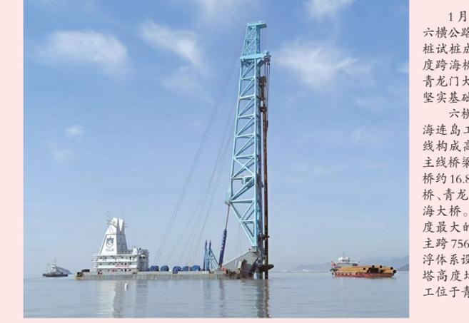
1月31日,浙江宁波舟山港六横公路大桥二期工程首根钢管桩试桩成功,拉开了国内最大跨度跨海桥梁海上施工的序幕,为青龙门大桥的主体结构施工打下坚实基础。
