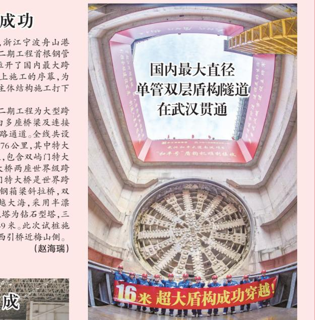
2月1日,中铁十四局承建的国内最大直径单管双层盾构隧道——武汉和平大道南延工程隧道顺利贯通,此次贯通为打通城市断头路、同时保护古城遗迹和风景名胜开发利用地下空间提供了成功案例。此次贯通的隧道,为单管双层双向六车道,设计速度为每小时50公里。2021年8月29日,一台开挖直径达16.03米的盾构机,由中山路“武胜门”遗址区域始发掘进,至黄鹤楼南路接收,隧道下穿武昌古城、蛇山,地质条件复杂,距运营地铁5号线隧道水平距离仅有10米,是国内施工技术含量和难度较高的隧道之一。据介绍,为确保盾构机顺利完成掘进,中铁十四局项目部不仅成立盾构技术专家组,对盾构机选型设计及施工难题进行指导把关,还在掘进过程中,应用自动化监测施工技术,对沿线敏感建筑物布设观测点,实时监测沉降数据,同步调整掘进参数,实现了安全平稳穿越。(刘福昌 杨路)
