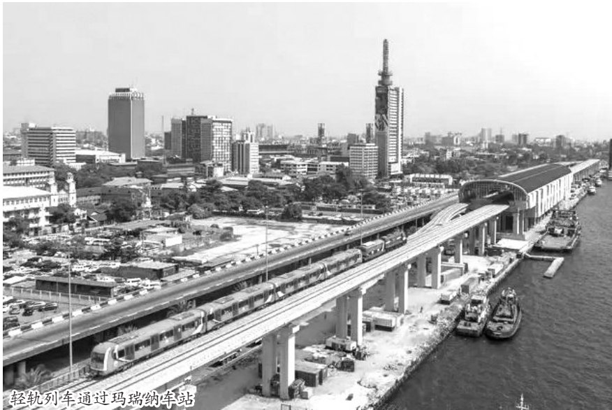
轻轨列车通过玛瑞纳车站
