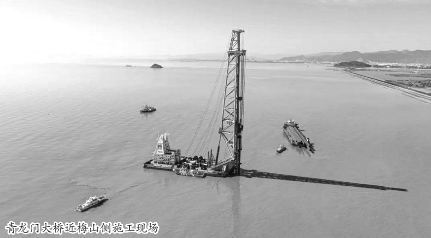
青龙门尖桥近梅山侧施工现场
