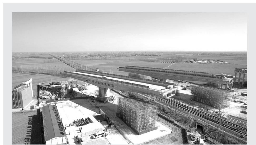
近日, 由山东高速集团投资建设的济南绕城高速公路二环线西环段项目(以下简称济南西环项目)重要控制性工程之一的上跨邯济铁路转体桥成功转体。济南西环项目上跨邯济铁路立交工程为(62+62)米转体连续梁, 梁体施工采用支架现浇施工工艺, 单幅梁体重达10096吨, 在K212+593处交叉, 两幅梁体同时进行逆时针转体。桥梁左幅转体73度, 右幅转体74度, 由南至北分别上跨邯济铁路下行线、上行线。 常青 摄影报道
