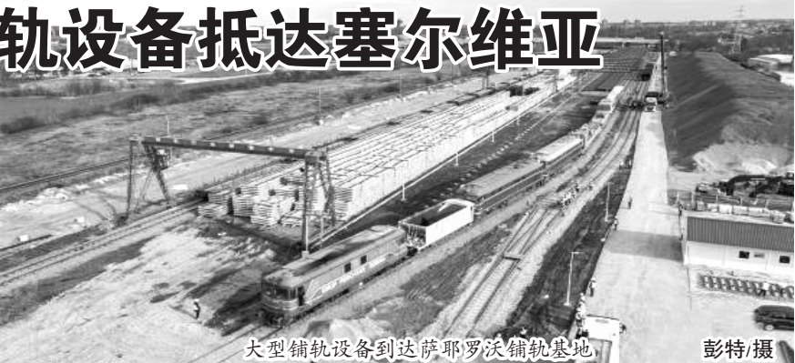
大型铺轨设备到达萨罗沃铺轨基地
