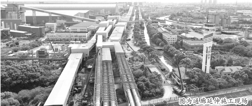
图为通廊延伸施工现场
