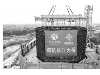
近日,由湖北交投投资建设,中交二航局承建的燕矶长江大桥南岸主塔完成首节钢筋部品吊装,并实现精准对接。这标志着项目建设进入筑塔机智能施工新阶段。
