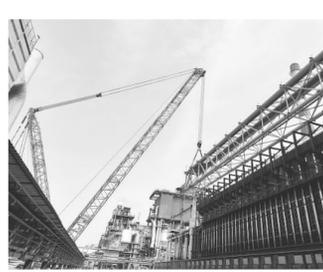
日前,中国五冶集团承建的河北华丰焦炉烟气治理项目仅用7小时顺利完成该项目三分厂3号焦炉侧主桁架的吊装工作,比原计划提前4小时,为业主生产、炉体稳定提供了保障。通讯员 赵洪浩 摄影报道
