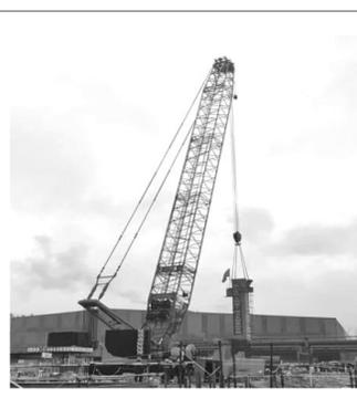
近日,上海二十冶承建的联峰钢铁炼钢三厂扩建工程炼钢连铸主厂房工程塔楼框架第一根钢柱顺利吊装。这标志着工程进入钢结构安装初始阶段。
