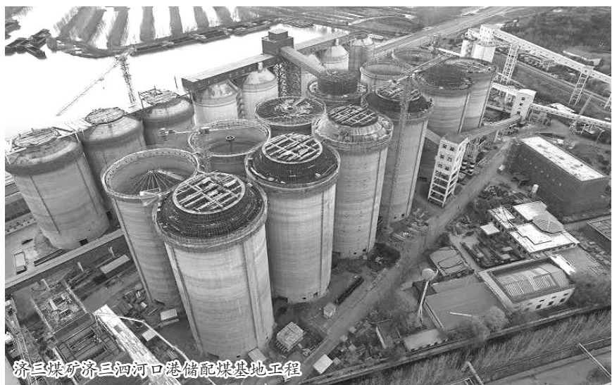
济三煤矿泗河口港储配煤基地工程
