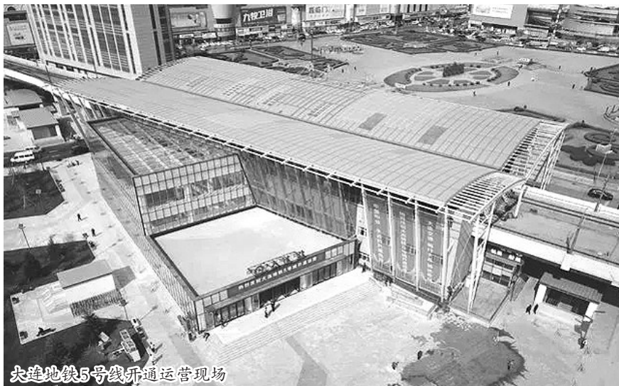
大连地铁5号线开通运营现场
