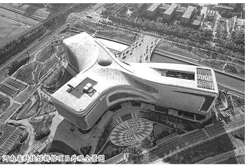
河南省科技馆新馆项目外观全景图
