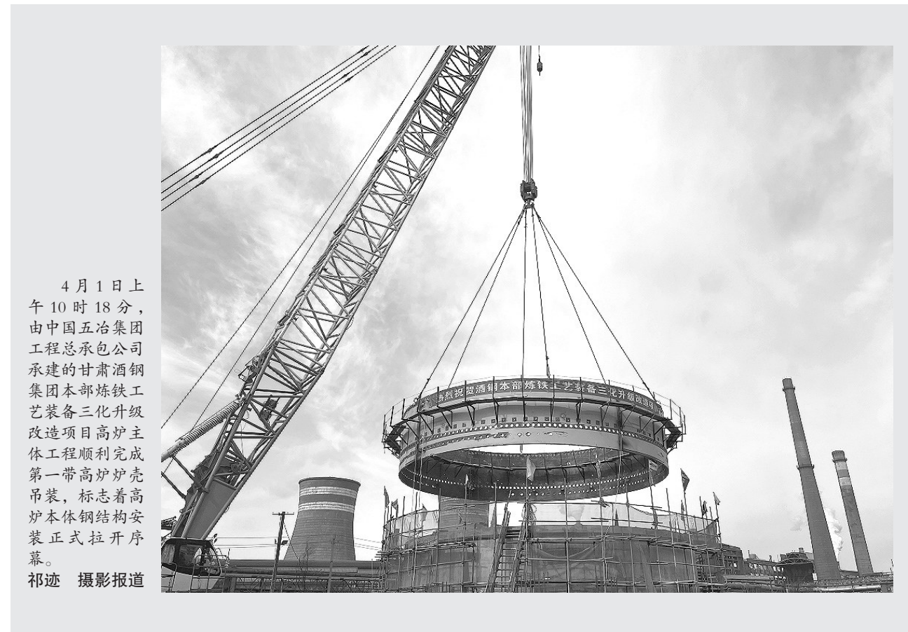
4月1日上午10时18分,由中国五冶集团工程总承包公司承建的甘肃酒钢集团本部炼铁工艺装备三化升级改造项目中高炉本体工程顺利完工,标志着高炉本体钢结构安装正式拉开序幕。
