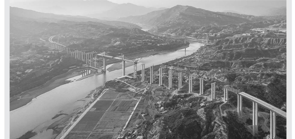
4月10日,沿江高速公路(宜宾至攀枝花高速)控制性工程——位于四川省攀枝花市的钒钛高新区大桥主桥合龙。沿江高速攀宁段路线全长166.167公里。其中,钒钛高新区大桥工程全长3.535公里,最高墩身116米,是四川省内第一高墩塔斜拉桥,也是沿江高速公路两个控制性工程之一,由四川路桥集团大桥工程分公司承建。唐子晴 摄影报道
