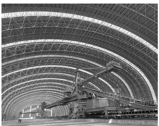
日前,由中国五冶集团工程总承包公司承建的云南玉昆钢铁项目原料厂一次料场B型库皮带机联试完成、场地平整完成。这标志着原料厂一次料场B型库顺利达到投产条件。
