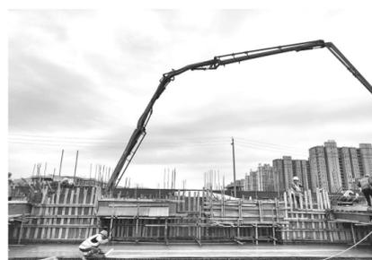
近日,由上海宝冶承建的浙江省绍兴市诸暨市城市有机更新项目一城市安居工程(东山吴地块)顺利完成首块地下室顶板浇筑。这标志着项目主体结构正式迈入“正负零”阶段。
