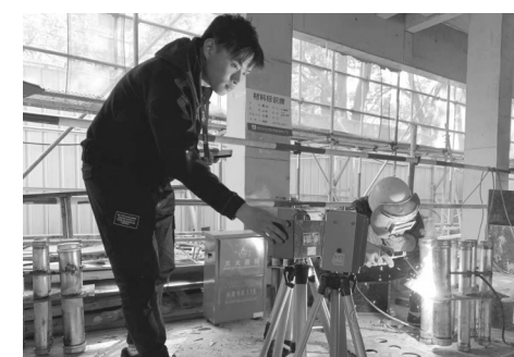
在第21个《职业病防治法》宣传周到来之际，杭州建工集团采取线上和线下相结合的方式，广泛深入开展职业病防治宣传。同时，该公司还将通过问卷调查、走访反馈等方式，了解职工健康需求和工作生活习惯，定期组织员工体检，建立和完善职工健康档案，持续关注员工身心健康。图为杭州建工集团所属杭州设备设备安装公司委托专业检测机构对施工项目的工作环境进行检测，让一线工人清晰了解自身作业环境情况。
