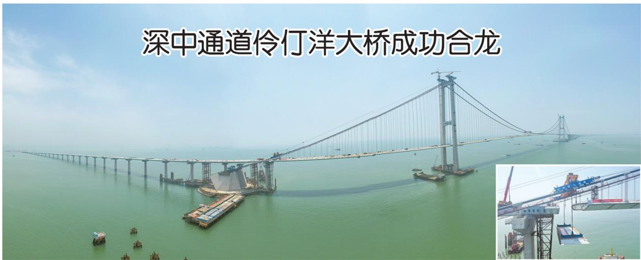
4月28日,广东省交通集团发布消息,国家重大工程深中通道伶仃洋大桥合龙,标志着项目桥梁工程实现全线合龙。深中通道连接珠江口东岸的深圳和西岸的中山市,是粤港澳大湾区重要枢纽工程,全长约24公里,是集“桥、岛、隧、水下互通”于一体的跨海集群工程。其中跨海段长22.39公里,行车时速100公里,采用双向八车道高速公路技术标准。中交二航局承建的
