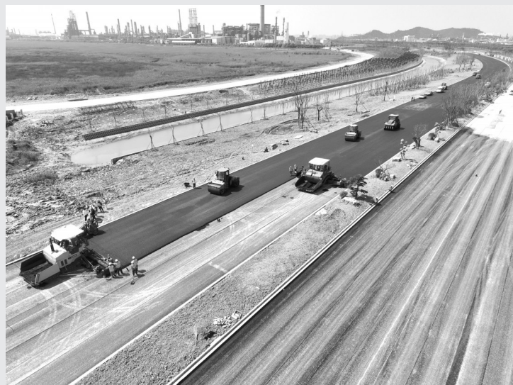
5月1日，在浙江二建杭甬高速复线湖涌互通连接线工程三期项目施工现场一片繁忙景象，机声隆隆，浙江二建百余名建设者在30多米宽的项目主干道紧张作业。 通讯员 王马飞 摄影报道
