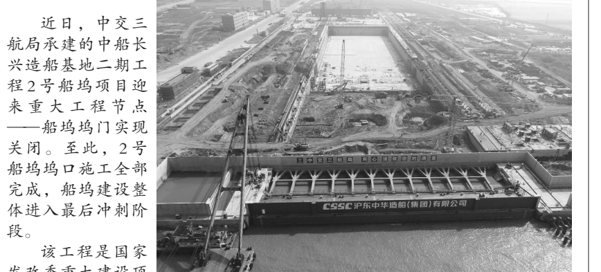
近日，中交三航局承建的中船长兴造船基地二期工程2号船坞项目迎来重大工程节点——船坞坞门实现关闭。至此，2号船坞坞门施工全部完成，船坞建设整体进入最后冲刺阶段。 该工程是国家发改委重大建设项目和上海市重点工程，于2021年9月30日开工建设，合同工期730天。 通讯员 黄铨 徐帅 摄影报道
