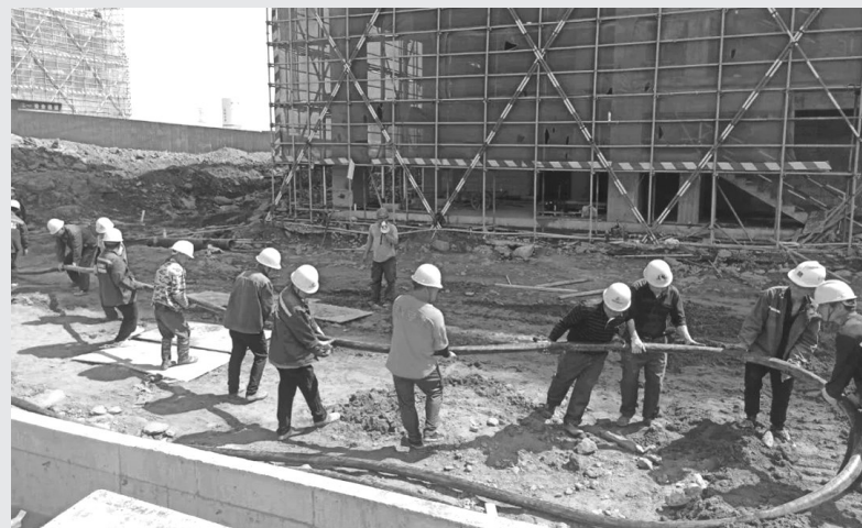
抢时间，赶进度，不停工，忙生产。五一假期，江西建工安装各重大施工现场仍是一派繁忙场景。建设者坚守在各自工作岗位上奋战一线，确保项目建设稳中有序推进。图为江西建工安装上饶江铜锂电铜箔项目现场。 通讯员 廖星 胡灵因 涂妍 摄影报道
