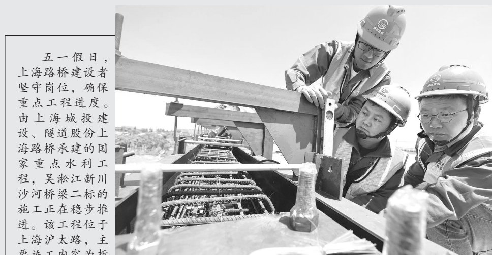
五一假日，上海路桥建设者坚守岗位，确保重点工程进度。由上海城投建设、隧道股份上海路桥承建的国家重点水利项目，吴淞江新川沙河桥梁二标的施工正在稳步推进。该工程位于上海沪太路，主要施工内容为拆除重建沪太路飞云桥，目前已完成西幅桥桥梁主体结构施工，正在施工桥面附属结构及主线道路。 张海峰 冯满莹 摄影报道
