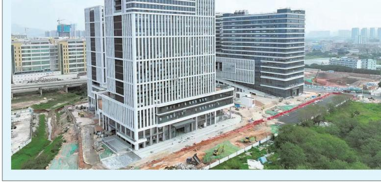
近日,由中建科技设计、制造、建造的国内首个全装配式“摩天工厂”——深圳坪山新能源汽车产业园区一期竣工交付。该项目占地10.78万平方米,厂房共17层,将提供超过32万平方米的产业空间。“工业上楼”指在高层大厦中进行企业的生产、办公、研发、设计的新型工业楼宇模式,通过将重量较轻、震动较小的生产设备迁移至高层,实现立体式开发。为方便企业在“摩天工厂”生产,该项目建设了立体化货运通道,大型货车可开到3层进行运输装卸,轻型货车则可直接开到顶层。项目经理鲁晓通介绍,这样的设计模式提高了土地使用率,还解决了产业配套问题,让建筑的“上下楼”变成产业的“上下游”。坪山新能源汽车产业园区项目一期工程还应用多项装配式建筑新技术、新工艺,在施工现场通过“搭积木”方式进行组架,实现了主体结构全装配。“这不仅减少了45%以上的碳排放,还节约了16%左右的施工费用。”鲁晓通说。(钟健)
