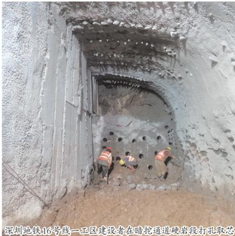
深圳地铁16号线一工区建设者在暗挖通道硬岩段打孔取芯
