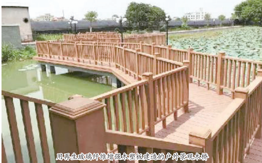
周再生玻璃纤维增强塑料板建造的户外景观木桥
