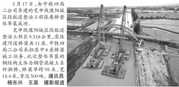
5月17日,由中铁四局二公司参建的芜申线深阳城区段航道整治工程张巷桥整体吊装成功。芜申线深阳城区段航道整治工程长9.518公里,需改建河道桥梁共11座。中铁四局二公司承担其中8座桥梁施工任务。此次整体吊装的钢结构主体为钢管混凝土系杆拱桥,桥梁单跨95米,宽14.4米,重达500吨。通讯员 杨东兴 王昊 摄影报道
