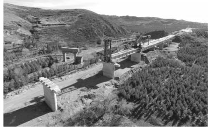
近日,随着架桥机将重125.1吨的预制T梁稳稳地落在同家营子大桥桥墩上,宣告由中铁电气化局铁路工程公司参建的集通铁路电气化改造工程首榀T梁架设成功,拉开了全线箱梁架设施工的序幕。这标志着集通铁路电气化改造工程正式进入桥梁上部结构施工阶段。
