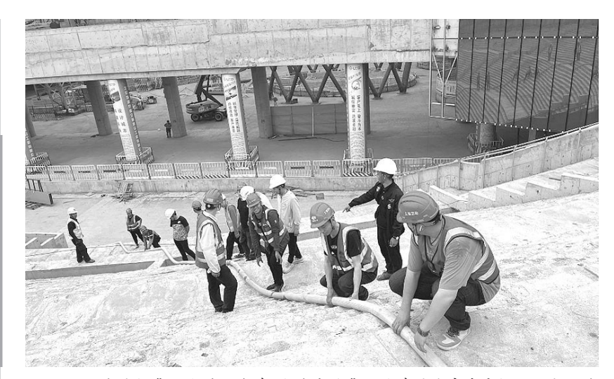
近日，由北投集团全过程代建、上海宝冶集团承建的北京城市绿心三大公共建筑共享配套设施1标段项目组织开展了防汛应急演练活动。防汛应急演练本着“安全第一、预防为主、统一指挥、分工明确、及时救援”的原则，各协作队伍共同参与，进行实战演练。经过各小组紧密配合，艰苦奋战，抢险任务顺利完成。通讯员 侯庆慧 摄影报道
