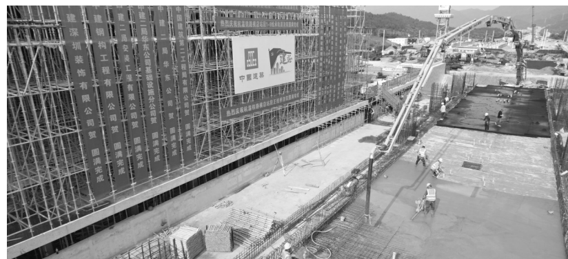
经过30个小时不间断浇筑, 6月11日, 中建二局华东公司承建的杭甬铁路建设工程站房工程1标项目正线桥浇筑顺利完成。
