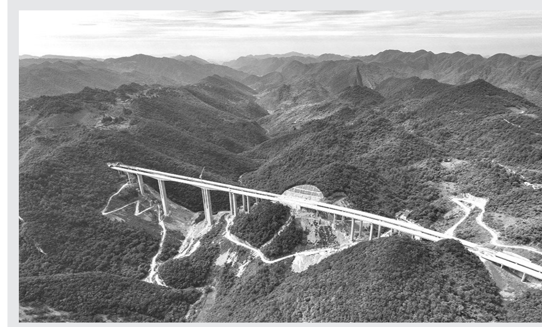
近日, 由中铁一局承建的贵州省遵义市桐梓县至新蒲新区高速公路重点控制性工程芭蕉湾特大桥架桥完成, 大桥左右幅全部贯通。芭蕉湾特大桥位于贵州省绥阳县视坝镇, 全长569米, 最大墩高135米。刘续 摄影报道
