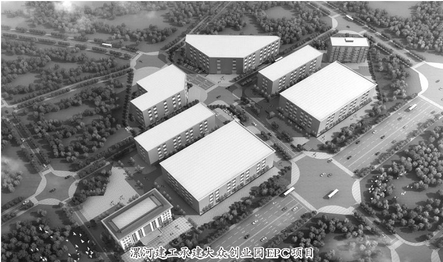
漯河建工承建大众创业园BPC项目
