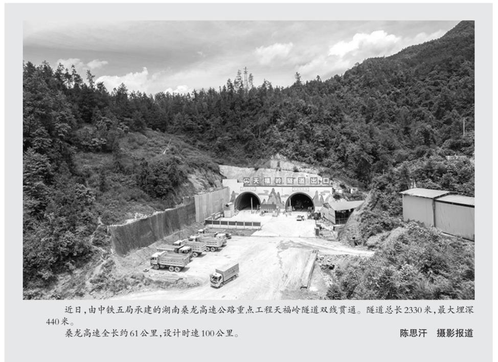
近日,由中铁五局承建的湖南桑龙高速公路重点工程天福岭隧道双线贯通。隧道总长2330米,最大埋深440米。桑龙高速全长约61公里,设计时速100公里。 陈思汗 摄影报道
