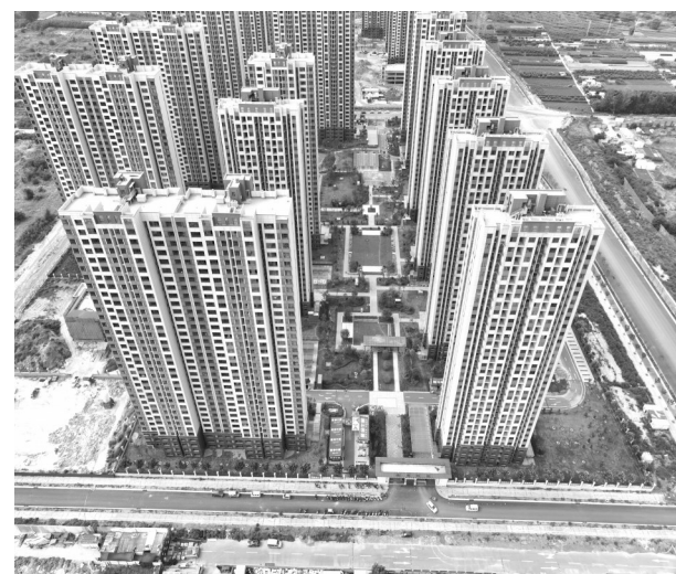
近日,由中建二局二公司建设的河南郑州高新区岳岗安置房建设项目B-04-01地块完工。
