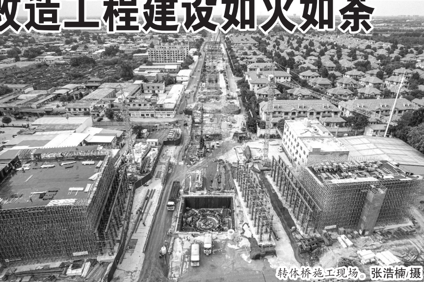
转体桥施工现场。张浩楠/摄
