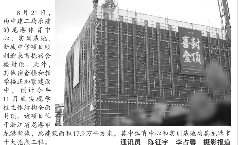
8月21日，由中建二局承建的龙港体育中心、实训基地、新城中学项目顺利迎来首栋宿舍楼封顶。此外，其他宿舍楼和教学楼正加紧建设中，预计今年11月底实现学校主体结构全面封顶。该项目位于浙江省龙港市龙港新城，总建筑面积17.9万平方米，其中体育中心和实训基地均属龙港市十大亮点工程。通讯员 陈征宇 李占馨 摄影报道
