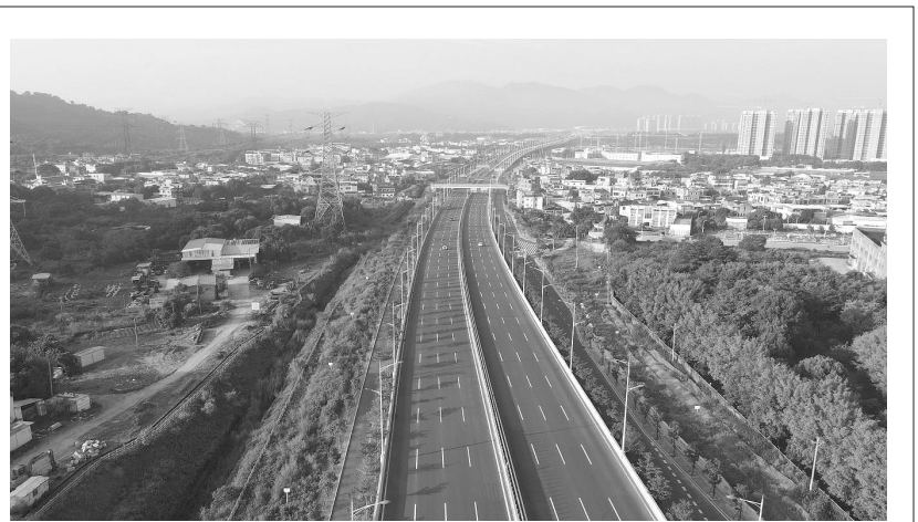
日前，由中交二航局漳州东环城路及其接线工程A1-2合同段作为东环城路最后一个标段顺利通过竣工验收。漳州东环城路是国道324线漳州境内重要路段和漳州城市快速路网的主要干道。东环城路竣工后，能够有效缓解漳州城区向东、向南的通行压力，对推动厦漳泉都市圈一体化发展具有重要意义。通讯员 卓靖顺 摄影报道
