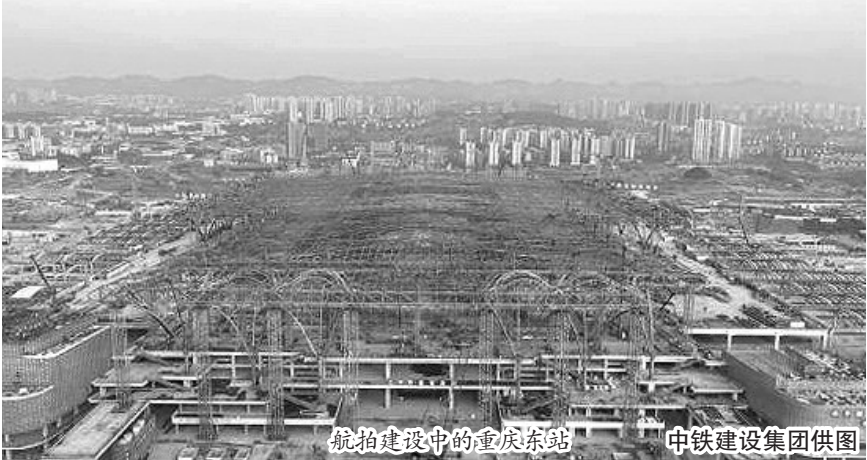
航拍建设中的重庆东站 中铁建设集团供图
