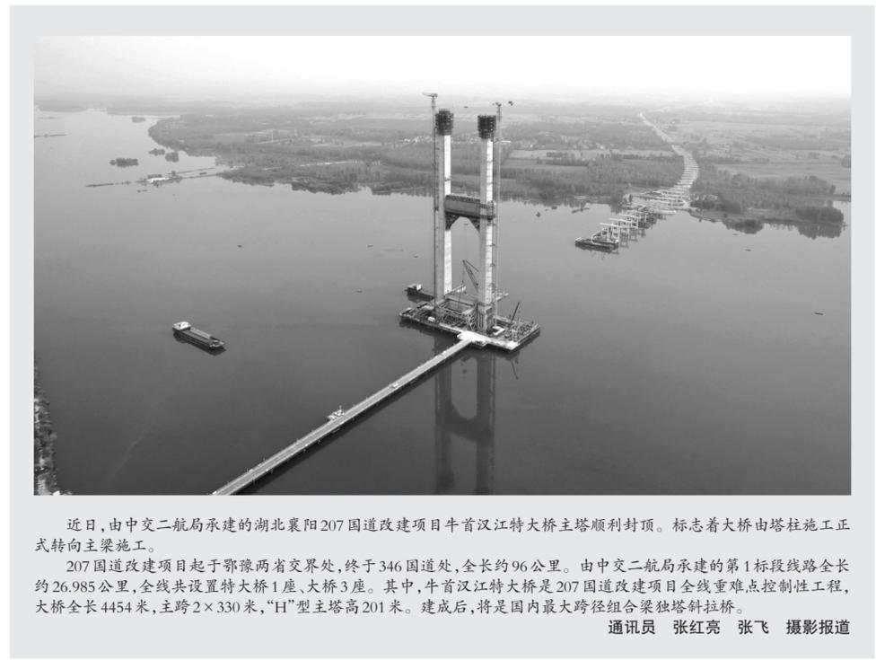
近日,由中交二航局承建的湖北襄阳207国道改建项目牛首汉江特大桥主塔顺利封顶。标志着大桥由塔柱施工正式转向主梁施工。
