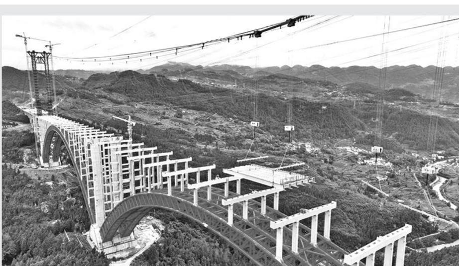
近日，渝湘复线高速公路双堡特大桥首节格子梁吊装完成。这标志着主桥正式进入上部结构施工阶段。双堡特大桥是渝湘复线高速公路关键控制性工程。该桥单幅桥面宽度16米，双向6车道。主桥采用2×405米双跨连续上承式钢混混凝土桁架拱桥，是世界在建跨径最大的双跨连续拱桥。该大桥单幅桥梁横桥向共6道格子梁，首跨格子梁长度为31.57米，重97.9吨，格子梁吊装单元由轨道运梁车运输至起吊点进行起吊安装，每次同时运输两个吊装单元。每个格子梁吊装单元上设置有8个吊点，利用单根缆索吊的两套跑车系统同时起吊运输。 郑三波 摄影报道
