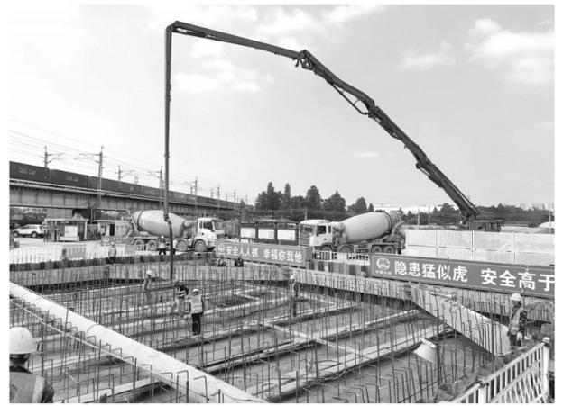
11月6日,由中铁广州局桥梁公司承建的广佛西环项目官窑西南涌特大桥3.1万吨转体斜拉桥转体主墩承台完成浇筑。
