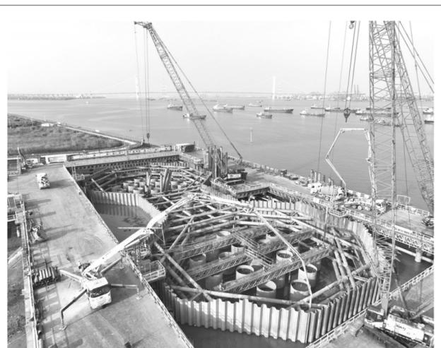
11月7日,由中交二航局承建的狮子洋通道项目主桥——狮子洋大桥西索塔承台封底混凝土浇筑完成。这标志着这座目前世界最大跨径双层悬索桥建设进入新阶段,为主塔承台出水 and 后续施工奠定基础,大桥将转为水上施工。
