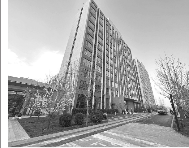
近日,由上海宝治北京分公司承建的中治总部基地南区项目顺利完成首批楼栋完工并交付物业单位,共计交付912户。 中治总部基地南区项目位于北京东燕郊国家级高新区核心,总建筑面积约21.5万平方米,包括科创办公、SOHO办公、高标商业等24栋单体。 通讯员 张宇 摄影报道
